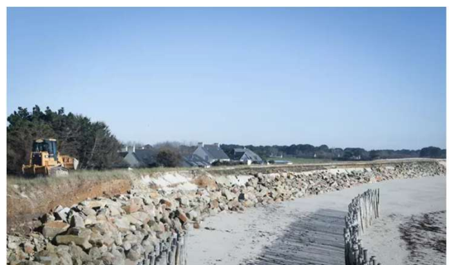
Maisons qui vont être détruites à Treffiagat (29). Crédits : Chloé Richard / Reporterre
